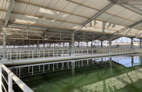
完成した浄水池
