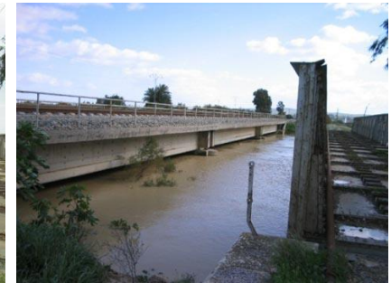
(写真右上) 本事業でかさ上げを実施予定の鉄道橋 (写真左上) 上の鉄道橋の洪水発生時の様子、橋の真下まで水が迫っており危険な状態に
