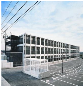
アイルームいなべ大安 (賃貸ワンルームマンション 78室)
