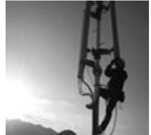
【情報通信設備工事】
