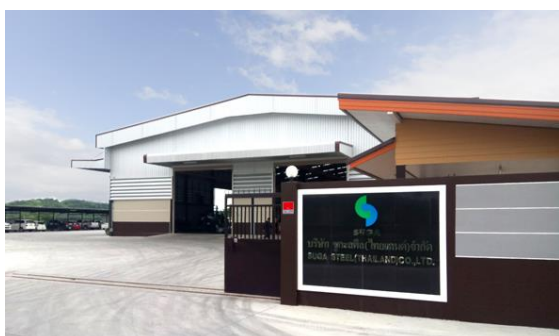
(スガスティール・タイ) 工場外観
