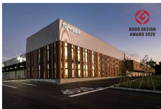
プレカット事業部 茨城工場 (茨城県坂東市)
