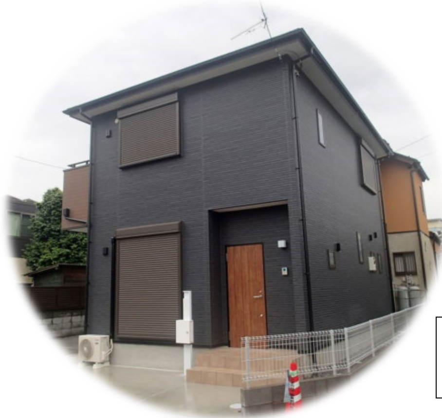
当社施工建築物 所在地：埼玉県さいたま市岩槻区 竣工年：2023年5月 プラン：木造2階建て 3LDK
