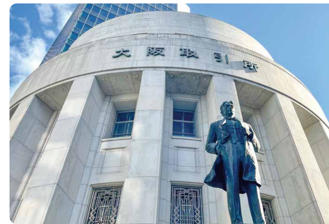
現大阪証券取引所ビル (2004年完成)
