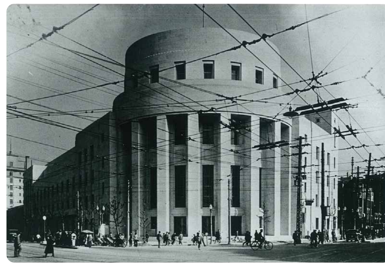
大阪証券取引所旧市場館 (1935年完成)
