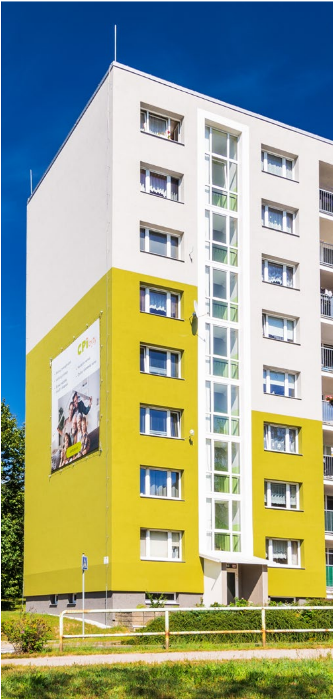
CPI BYTY, Česká Lípa, Czech Republic
