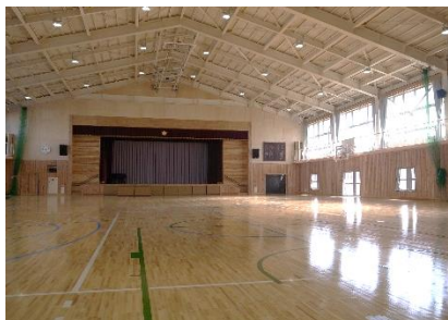
鋼製床下地及び床工事
