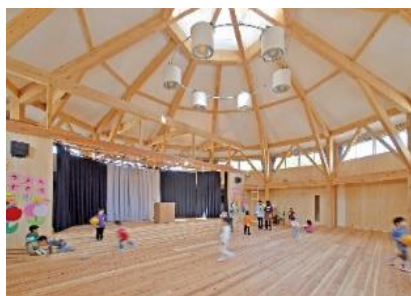
木大断面工事
