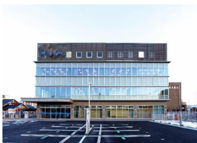
外壁押出成形セメント板工事
