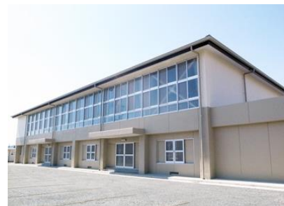
外壁押出成形セメント板工事
