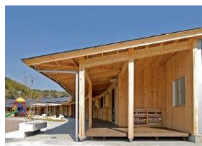
金属屋根工事
