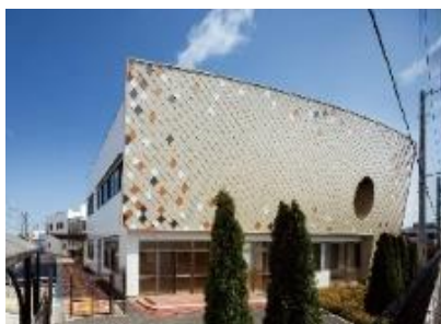
外壁押出成形セメント板工事
