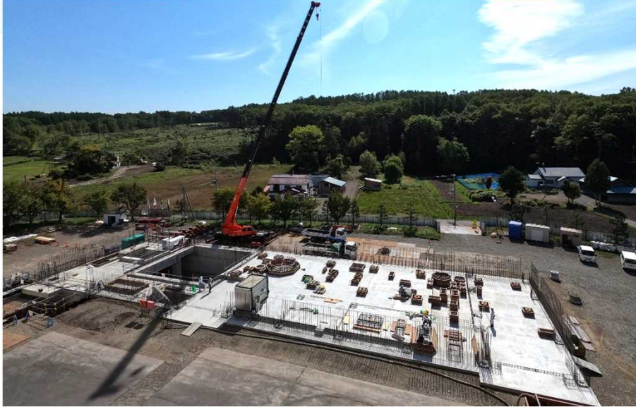
建設中の1号汚泥焼却施設
