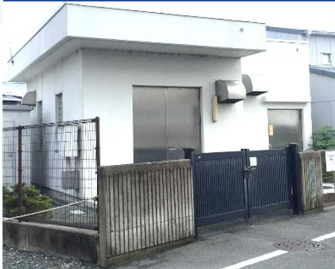
村櫛中継ポンプ場
