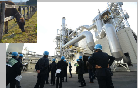
バイオマス発電所
