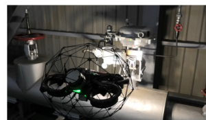
GPSの入らない屋内空間
