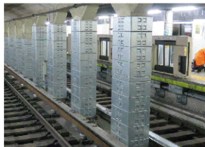
トンネル中柱補強
