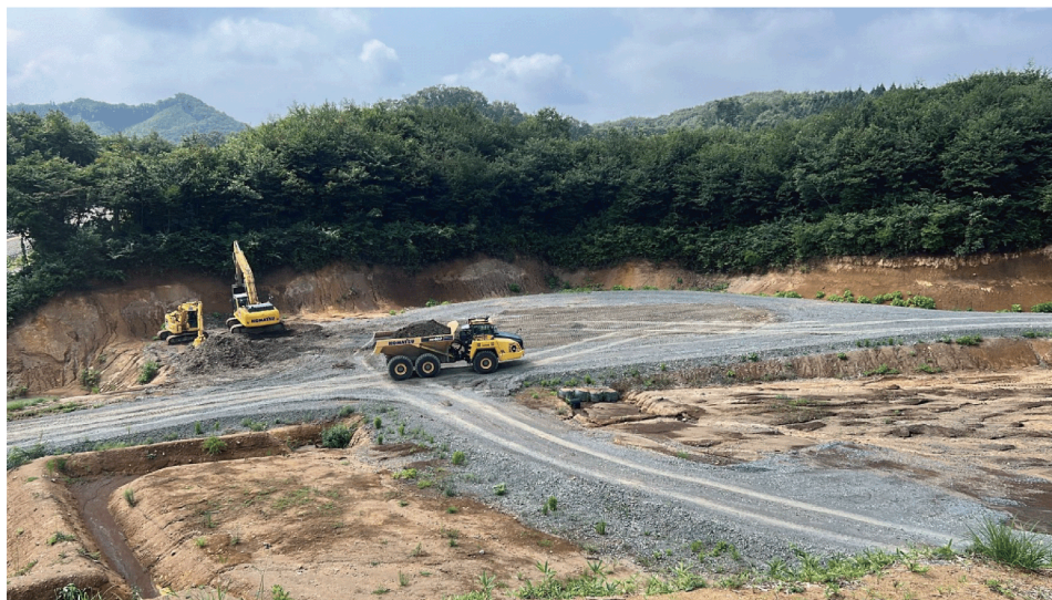
自動運転試験中のアーティキュレートダンプトラック（HM400）の走行の様子
