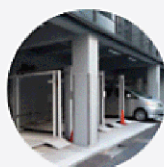
機械式駐車場
