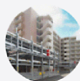
マンション付属 駐車場
